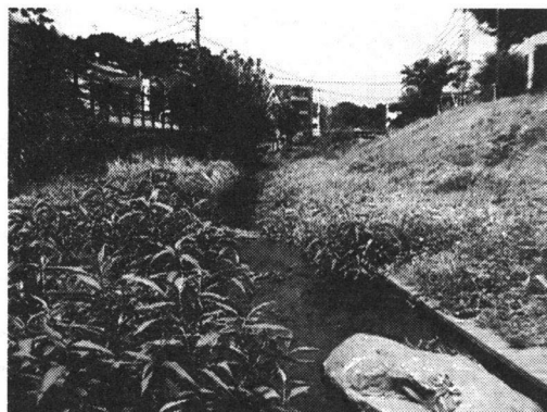
平瀬川水面から日向橋とクリニックを望む
