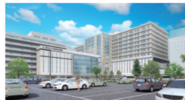
新病院完成予定図。入院棟棟は2023年、外来などを含め全体は24年完成する予定
